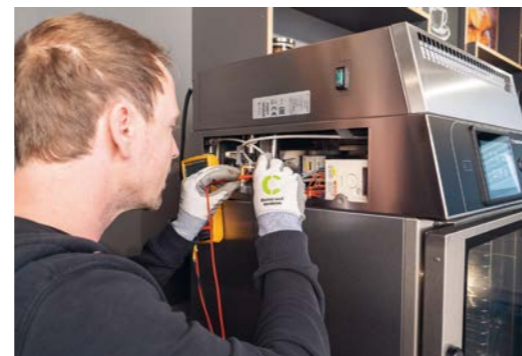
Die rundum servicefreundliche Konstruktion des Convotherm mini mit seinen vier Service-Ports macht die Wartung und Reparatur einfacher, schneller und kostengünstiger.
